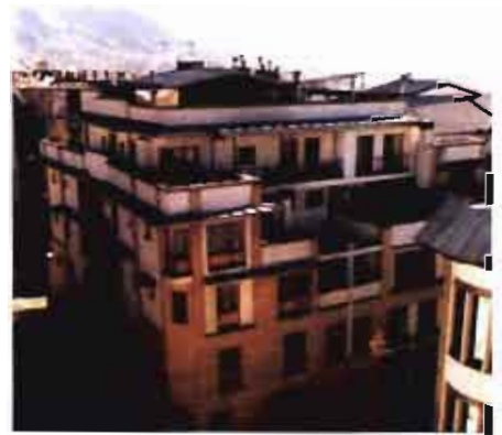
مجمع مسکونی لویه الهیه
